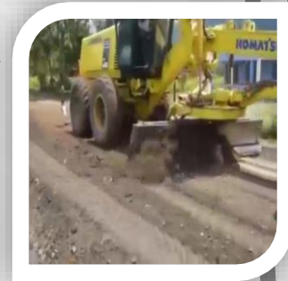
Fase 4. Mezclado del polímero y cementante con el material de sitio y nivelización de la vía
