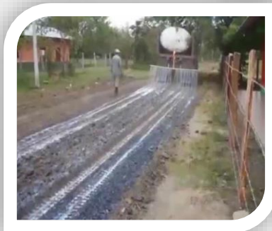
Fase 4. Mezclado del polímero y cementante con el material de sitio y nivelización de la vía
